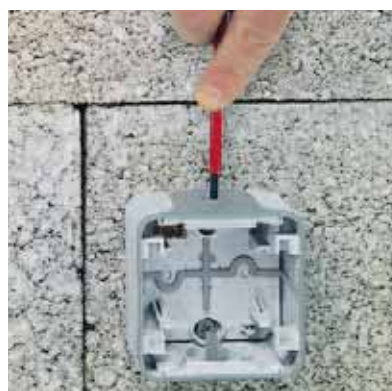
Durchstoßen der Membraneinführung mittels Schraubendreher
