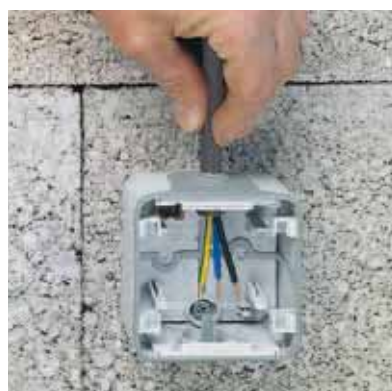
Zum Erreichen der Schutzart IP55 1) Kabel leicht zurückziehen
